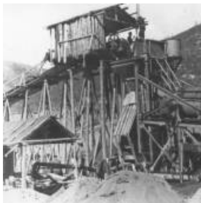
Struttura per l'estrazione dell'oro nelle cave adiacenti ad un lager della Kolyma
