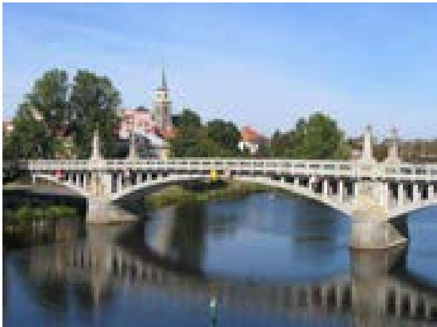
Ponte sull'Elba – Nymburk
